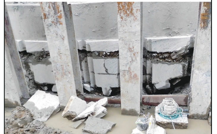
③ タワークレーン支持杭下の障害物
