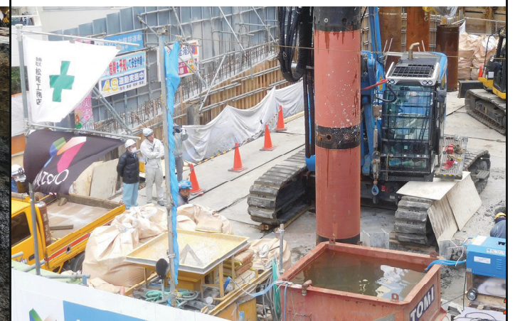
③ タワークレーン支持杭下の障害物
