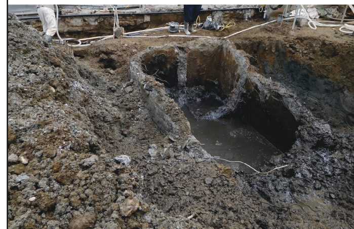
①-1 既存建物より前の構造体
