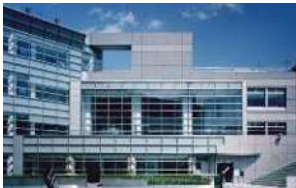
ガラス面フィルム更新 外壁シーリング更新
