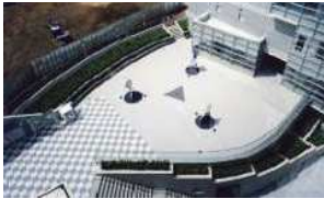
アートプラザ外部床改修
