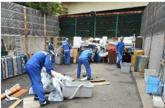
粗大ごみの積替え作業の様子
