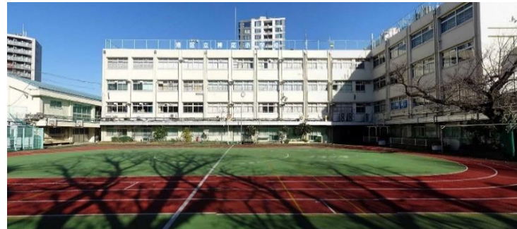
運動場側 現況写真
