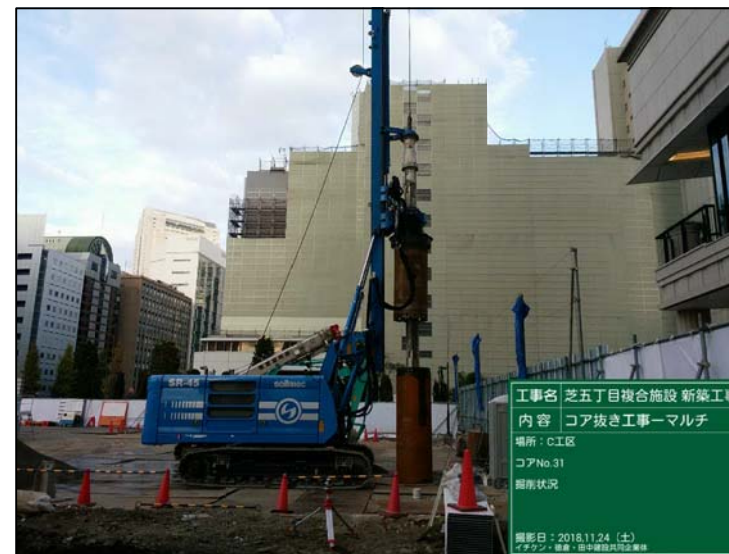
④多機能掘削機による先行掘削（工法）
