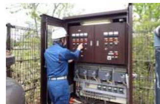
図 16-3 噴水設備制御調整
