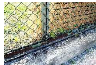
図 28-3-5 ドッグランの金網フェンス
