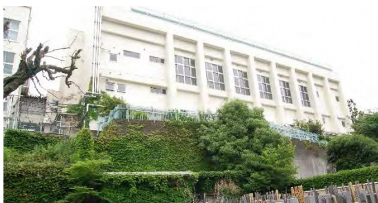
⑥隣地側(魚籃寺側)から敷地南側を見る
