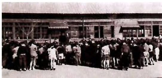
④『くぎひとにぎり運動』で建てられた校舎(昭和23年)
