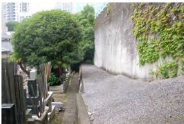
④西側擁壁・地下建物外壁
