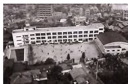
⑦鉄筋コンクリート造3階建ての校舎が完成(昭和41年)
