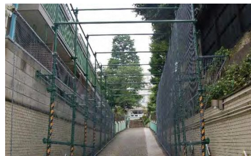
⑤前面道路から敷地入り口(御田門)を見る
