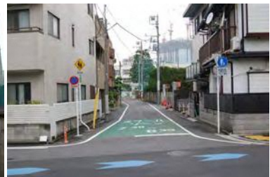
⑥幹線道路から区道 277 号線を望む
