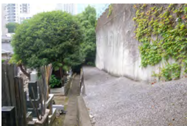
④西側擁壁・地下建物外壁
