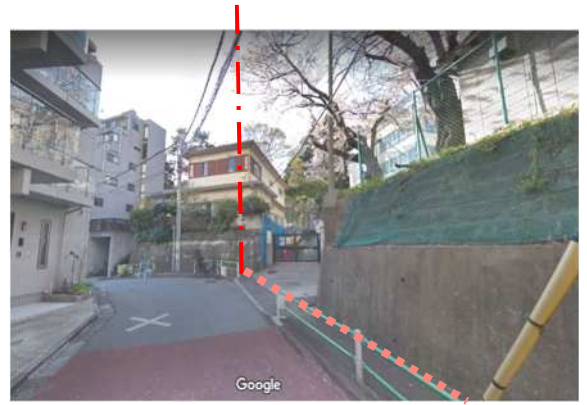
特別区道側接道部
