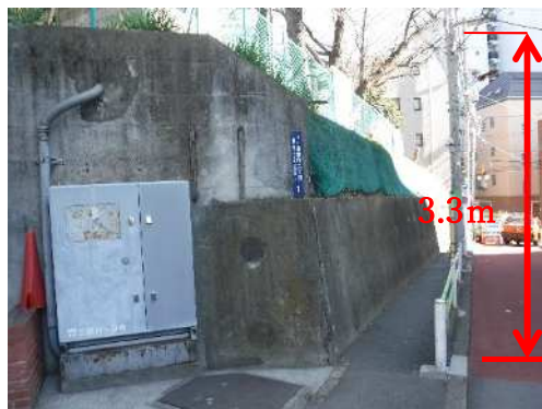
③ 特別区道よりプール側擁壁を望む
