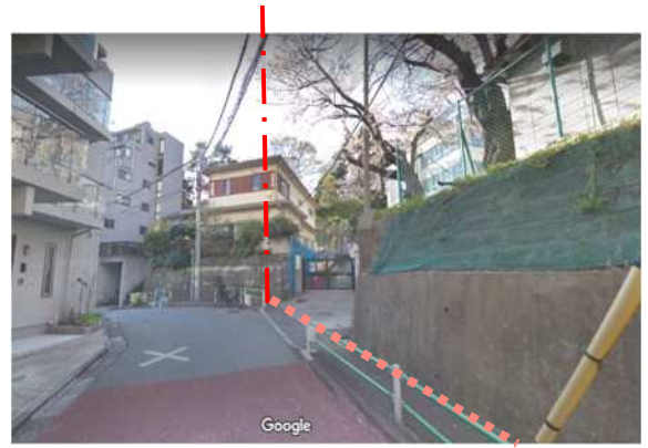
特別区道側接道部
