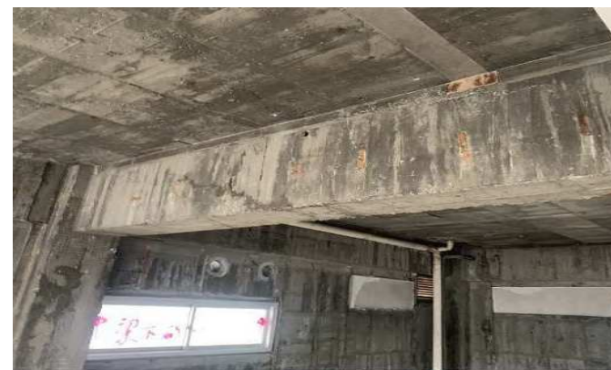
【既存躯体の補修面】
