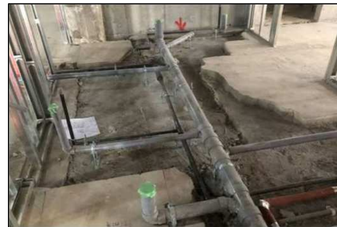
【床モルタルはつり作業】
