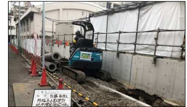
【外構掘削作業】
