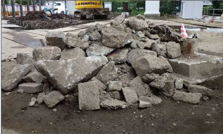
コンクリートガラ
