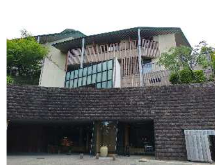
本館正面外壁面
