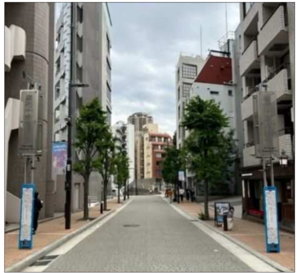
【整備後 (I 期工事)】
