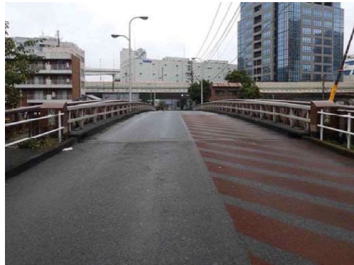
車道橋（芝浦二丁目側から撮影）
