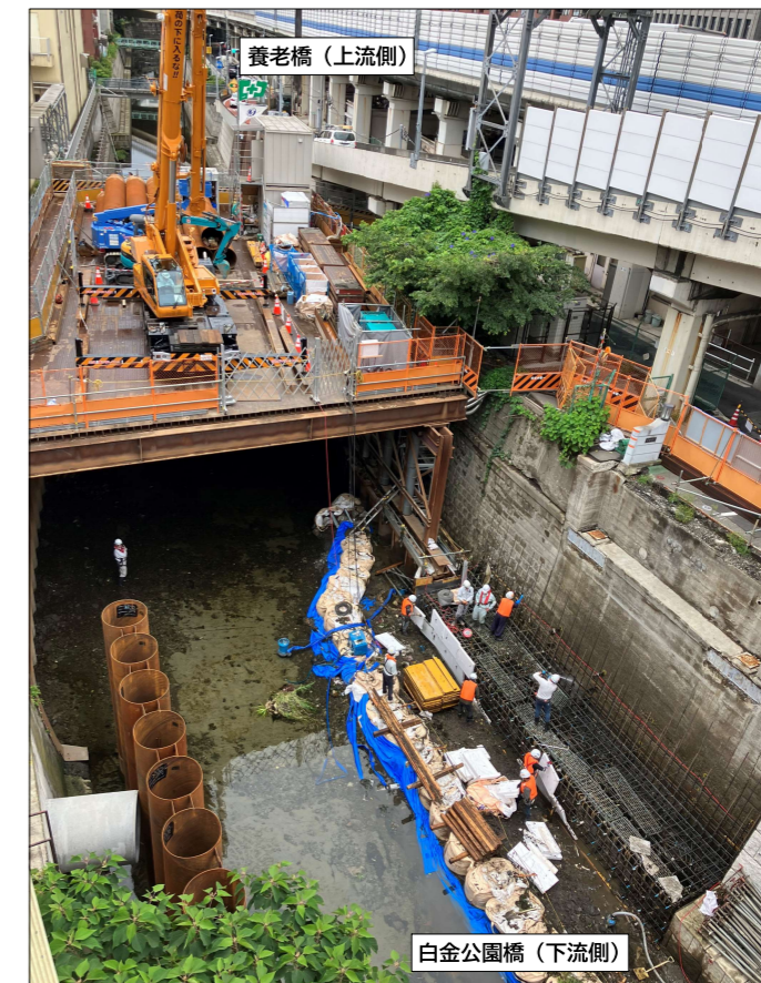
現場状況写真 (令和5年5月現在)
