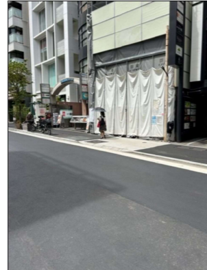
歩道舗装③(施工後)
