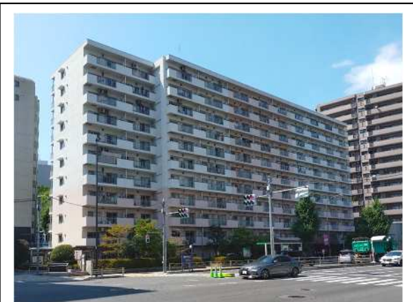
東側外壁（写真①）
