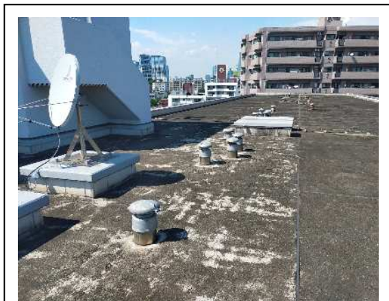
屋上（写真②）
