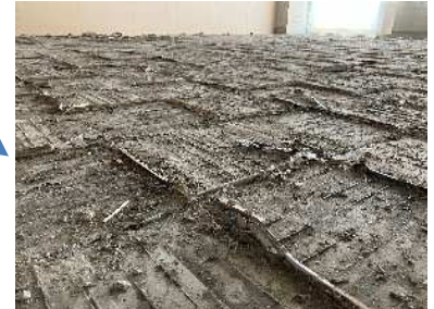
【床下地補修工事】
