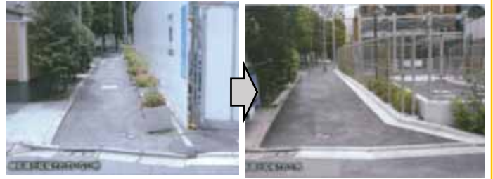
細街路拡幅前
