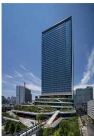
区内で民間初の津波避難ビル (東京ポートシティ竹芝オフィスタワー)
