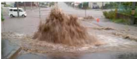
マンホールからの吹き上がり
