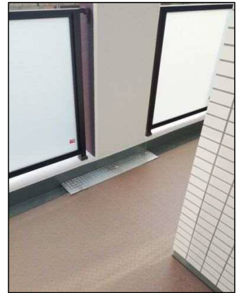
3 障害者支援施設バルコニー溝蓋設置
