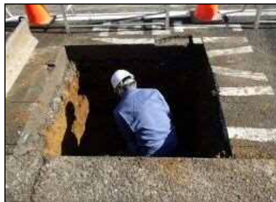
2 下水道接続工事に伴う試掘
