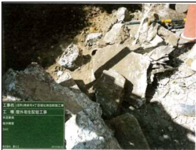
1 地中障害物処理
