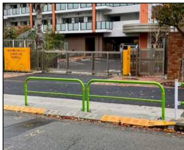
5 前面道路ガードパイプ設置
