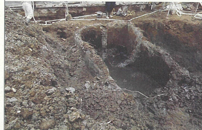
①-1 既存建物より前の構造体
