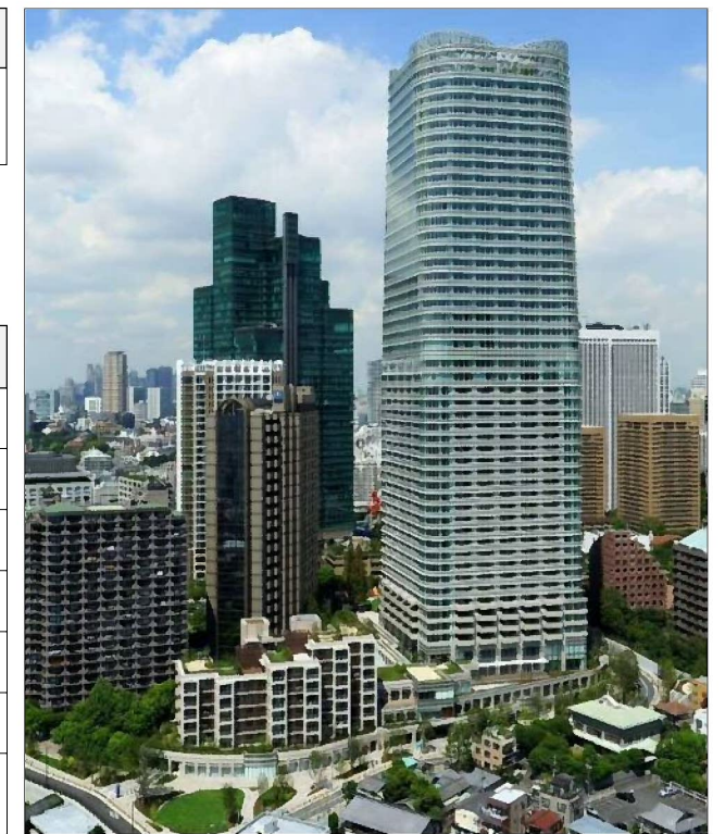
□完成写真（東側からの外観）
