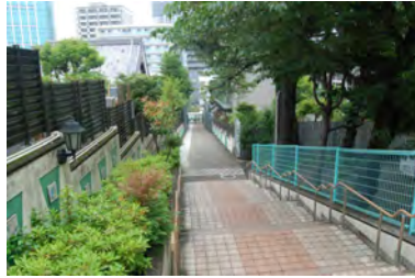
②北側構内通路
