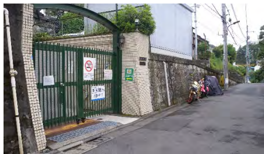
④前面道路から敷地入り口(御田門)を見る
