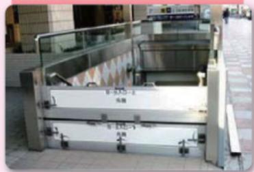
使用しないときは設置箇所の近くに防水板を格納し、使用時に運搬、設置し、金具の締め付け等により止水するタイプ。
