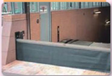
防水板が床面に収納されており、垂直に上昇するタイプで手動・自動がある。
