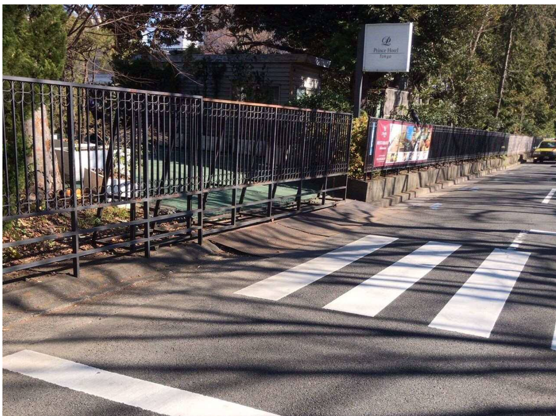
事故現場写真（近景）
