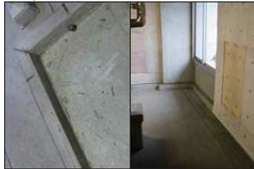
【Fig.4】ブースターポンプ室
