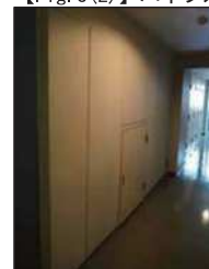
【Fig. 8(2)】パイプスペース(23階)
