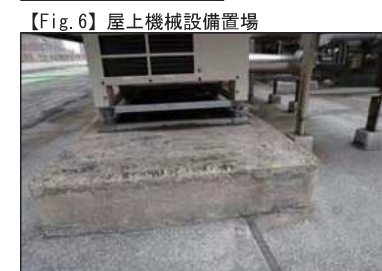
【Fig.6】 屋上機械設備置場
