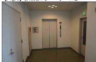
【Fig.3】 非常用エレベーターロビー
