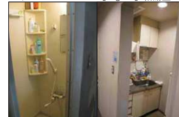
【Fig. 13】パイプスペース
