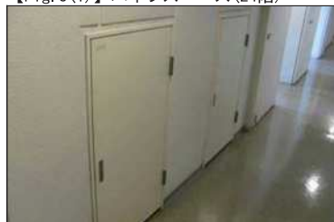
【Fig. 3(1)】パイプスペース(24階)
