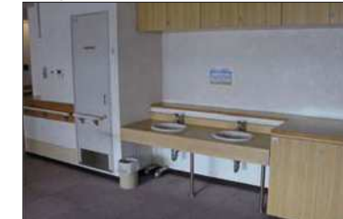
【Fig. 11】パイプスペース
