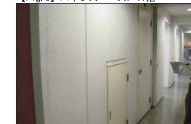
【Fig.6】パイプスペース/11階
