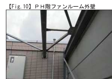
【Fig.10】 PH階ファンルーム外壁
