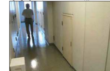
【Fig.5】パイプスペース/11階
