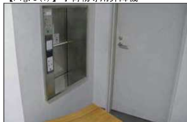
【Fig.3(1)】小荷物専用昇降機
