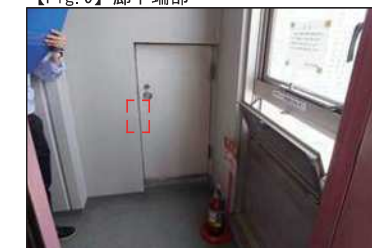
【Fig. 9】廊下端部
