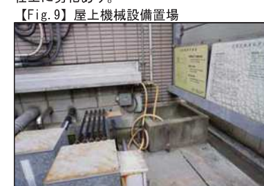
【Fig.9】 屋上機械設備置場
