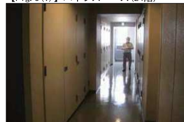
【Fig. 8(1)】パイプスペース(24階)
