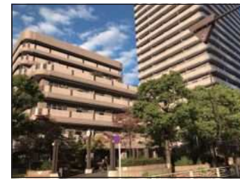
① 敷地南西交差点から外観
