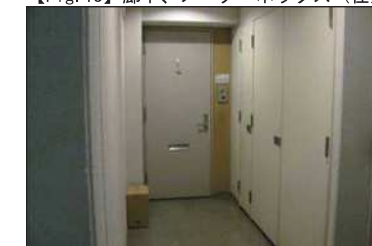
【Fig. 13】廊下、メーターボックス(住戸前)
