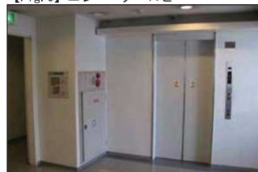
【Fig. 6】エレベーターロビー
