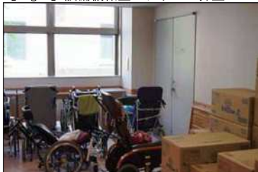
【Fig. 1】 設備機械室・アラーム弁室
