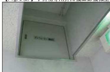
【Fig.3(2)】小荷物専用昇降機上部機械室
