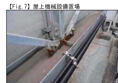
【Fig.7】 屋上機械設備置場
