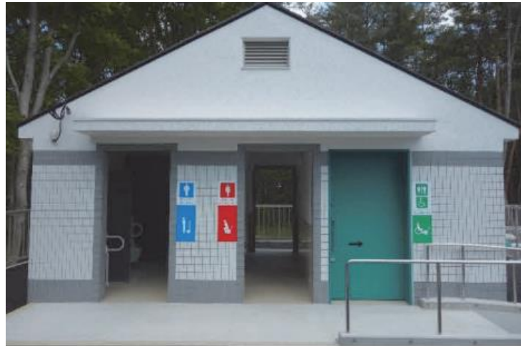
屋外トイレの整備
