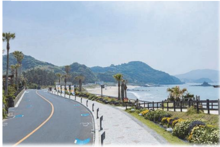
北崎地区の無電柱化された道路
