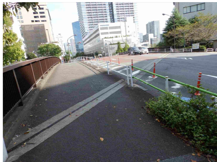
西側歩道部（芝浦二丁目側から撮影）
