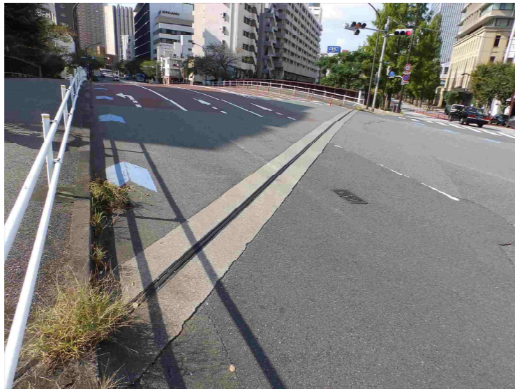
車道部（芝浦一丁目側から撮影）
