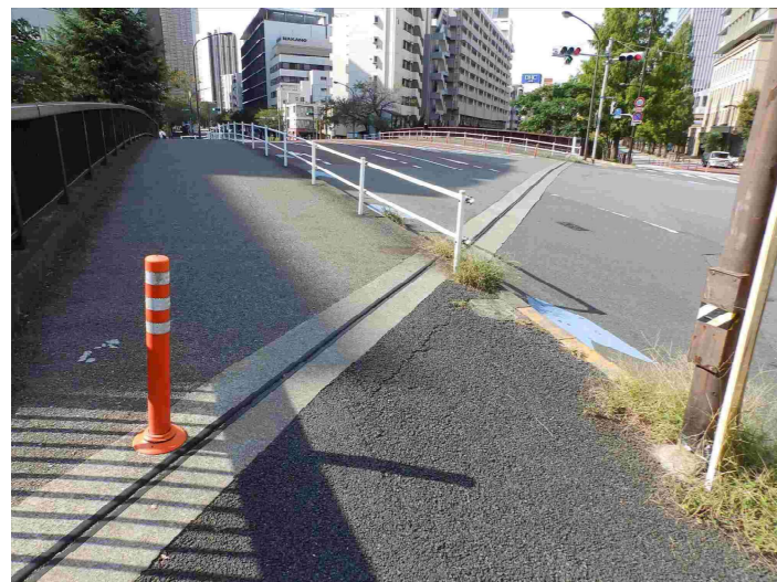
東側歩道部（芝浦一丁目側から撮影）
