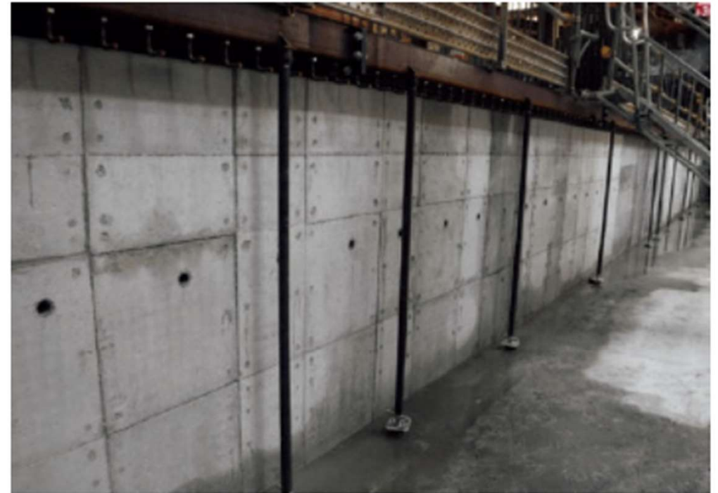
埋設型枠としての使用例
