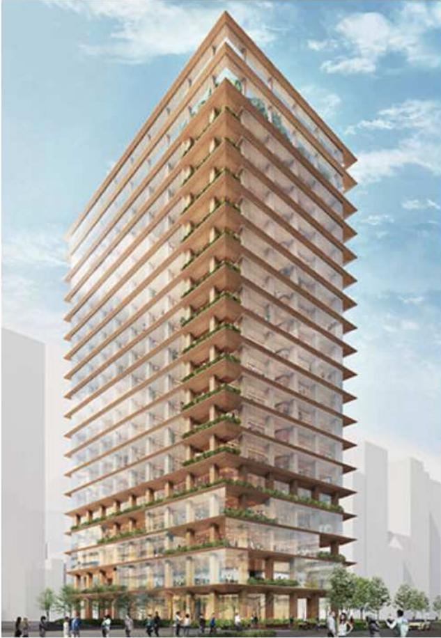
三井不動産と竹中工務店により日本橋にて進められている木造賃貸オフィスビル計画。主要な構造部材に、竹中工務店が開発した「燃エンウッド」と呼ばれる耐火集成材など、最先端の耐火・木造技術が導入される予定。木材は三井不動産グループが保有する森林のものをはじめ、国産が積極的に使用される。
