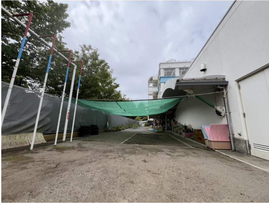
「にじのはし幼稚園」園庭砂場ロープ結束状態
