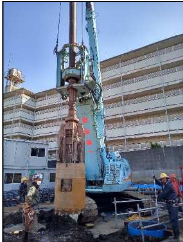
オールケーシング工法、グラブビットの使用の様子
