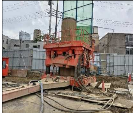
オールケーシング工法、グラブビットの使用の様子
