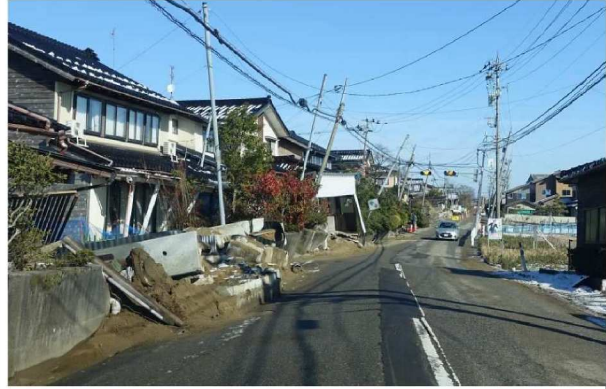
令和6年能登半島地震の被害状況 出典：石川県ホームページ
