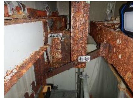
4階吊柱・直交梁・振止め
