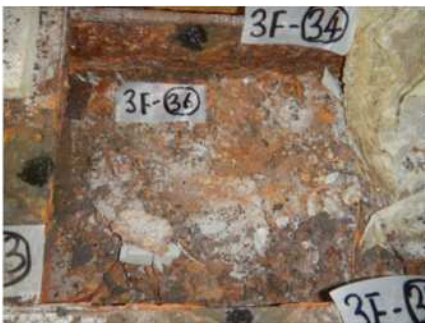
3階外壁支持鉄骨
