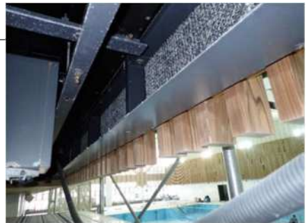
ルーバーを支える部材
