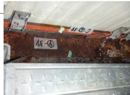
4階内壁支持鉄骨
