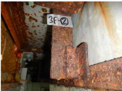
3階ECP(押出成形セメント板)下地
