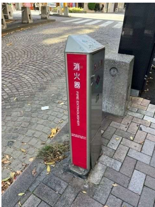
自立して置かれていた消火器格納箱
