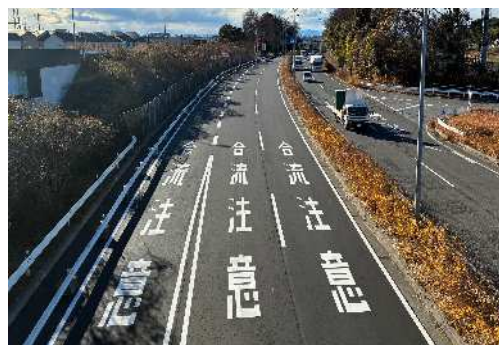
バイオ炭を混合したアスファルト施工例
