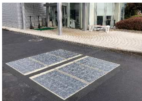
太陽光発電舗装 （写真提供）東亜道路工業株式会社
