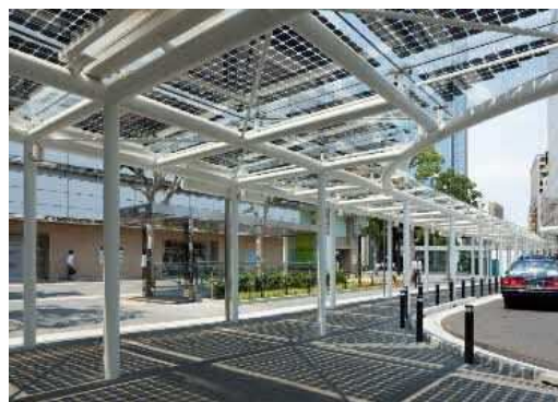
太陽光発電パネルを設置した タクシーシェルター（川崎駅東口）
