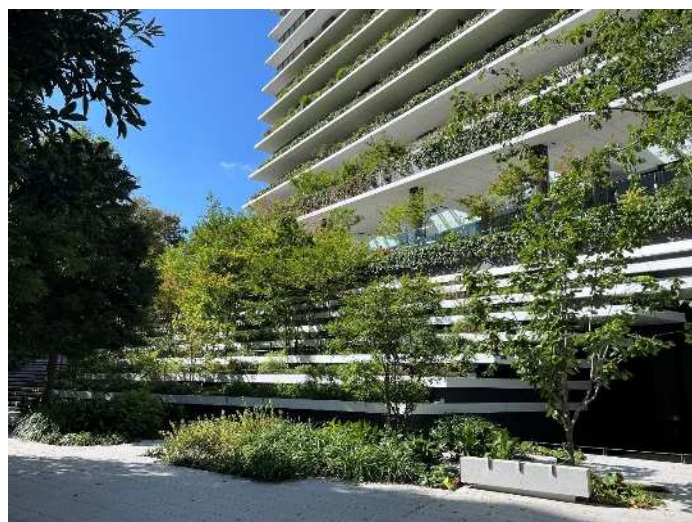
壁面緑化（虎ノ門ヒルズ レジデンシャルタワー）
