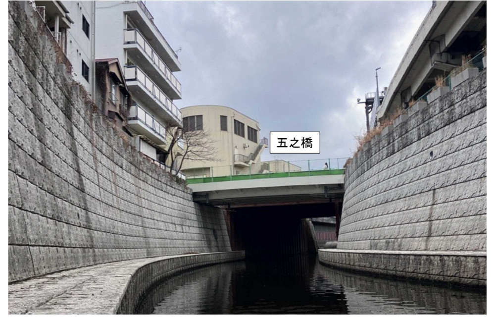
護岸整備済み箇所 現場状況写真
