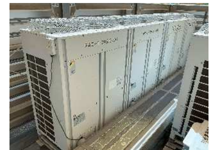
屋上 室外機置場
