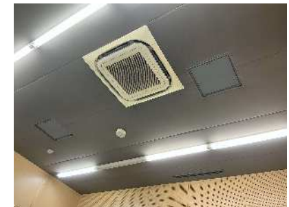
4階 多目的ホール
