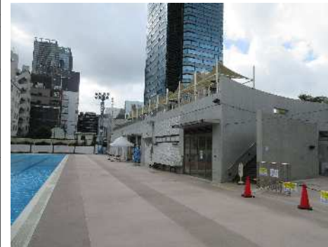
プールサイド側外壁
