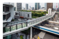
首都高速道路都心環状線をわたる歩行者デッキ ※7
