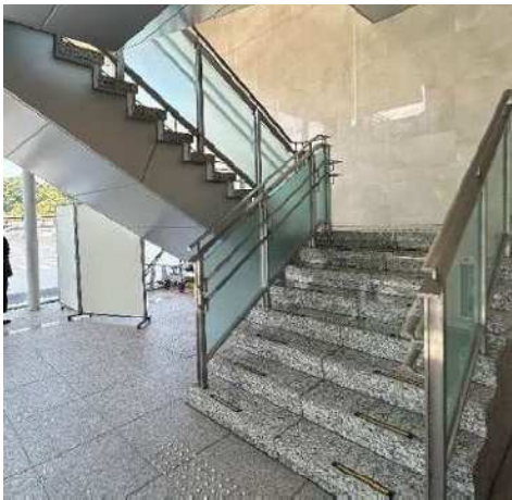
北側外装・鉄骨階段工事
