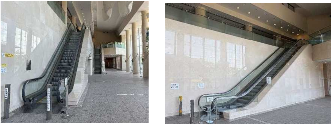
エスカレーター更新工事 左：のぼり 右：くだり
