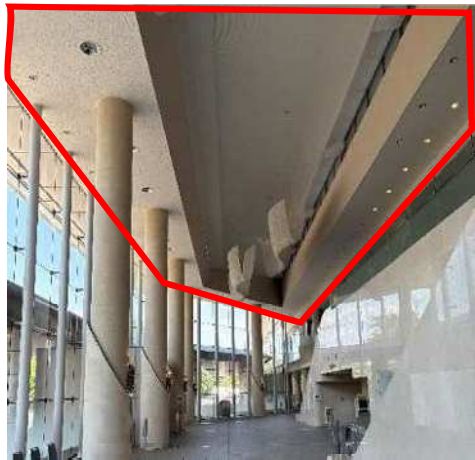
特定天井改修工事
