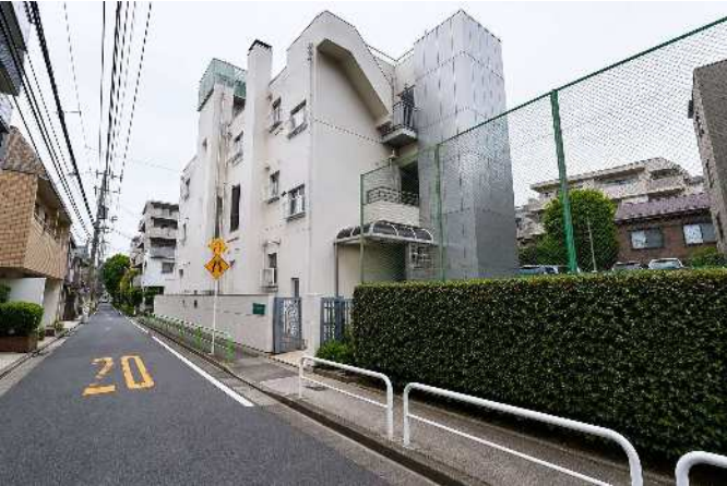
施設外観（北東側道路）
