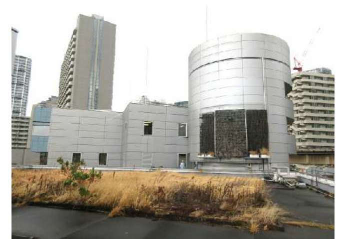
建物屋上(4階北)
