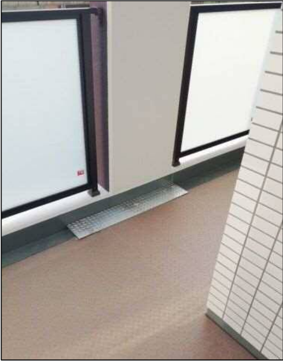
③-1 障害者支援ホームバルコニー溝蓋設置
