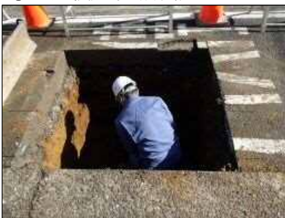
② 下水道接続工事に伴う試掘
