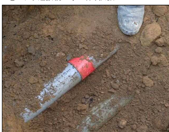
② 下水道接続工事に伴う試掘
