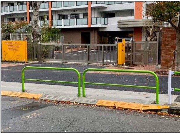
③-3 前面道路ガードパイプ設置
