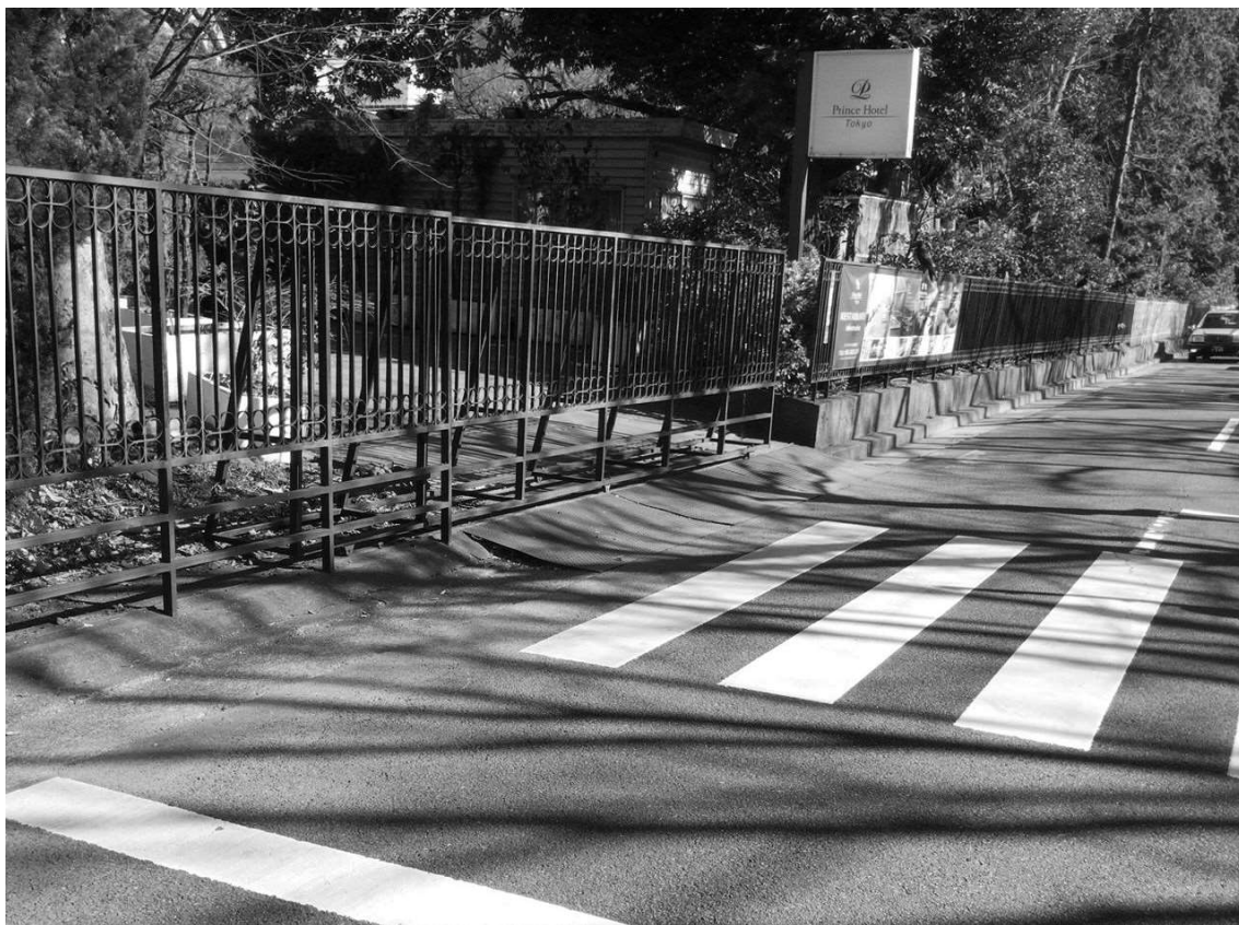
事故現場写真（近景）
